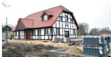
Trwają prace przy budowie parkingu i chodników
